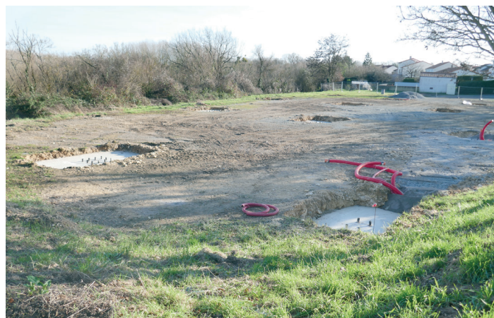
Travaux en cours au parking rue du Gué Rochelin
