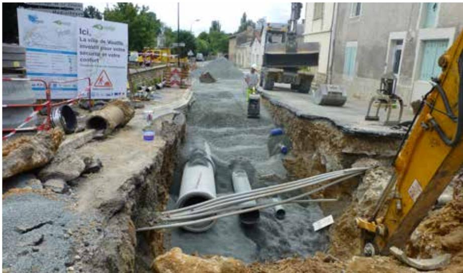
Un diagnostic a été réalisé en 2015, sur l'ensemble des réseaux d'assainissement. Celui-ci a révélé d'importants dysfonctionnements, pour lesquels un programme de réhabilitation a été arrêté sur plusieurs années. Il a démarré en 2016 par la réalisation de travaux rue du Gué Rochelin, rue de la Tour du Poile et chemin du Bois Merlot où les collecteurs ont été remplacés. Il se poursuivra en 2017 par du chemisage de réseaux dans plusieurs secteurs de la commune.
