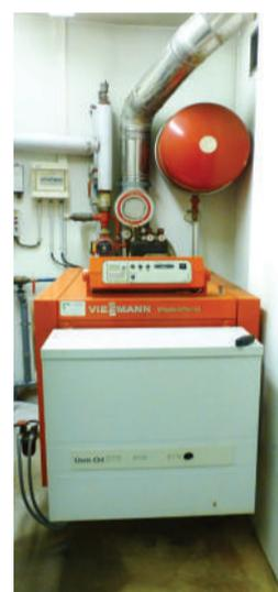
La chaudière à fioul, utilisée à la mairie, va être remplacée par une chaudière à gaz plus performante et plus économe en énergie.
